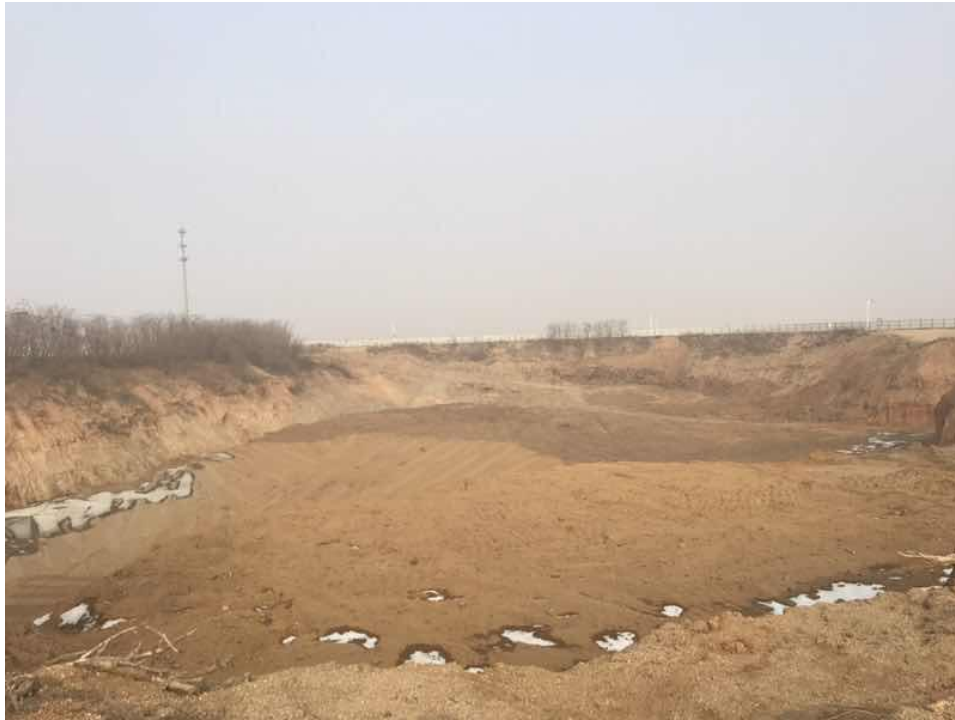
图 11 已有部分污泥坑完成污泥开挖及土方回填
